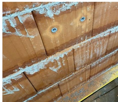
La muratura di tamponamento monolitica isolata facilita e migliora la possibilità di agganciare rivestimenti in facciata.
