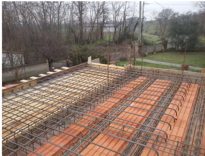
*Operazioni di posa dell'armatura delle corree, delle travi, dei balconi e posa del solaio in latero cemento spessore 28 cm*
