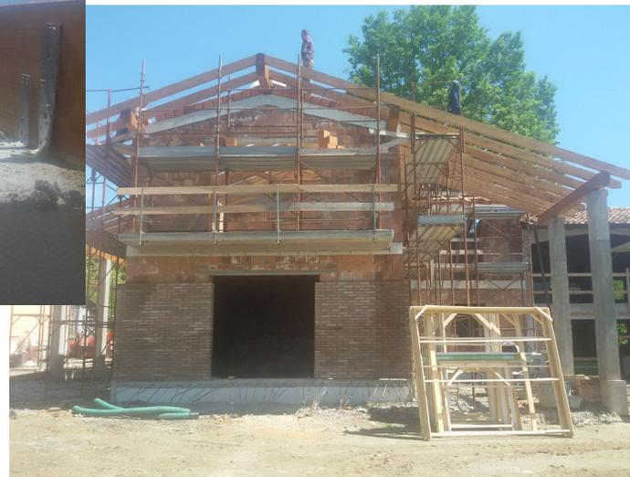
Villa sulle alture pavese: la ricostruzione di un fienile con la tecnica della muratura armata
