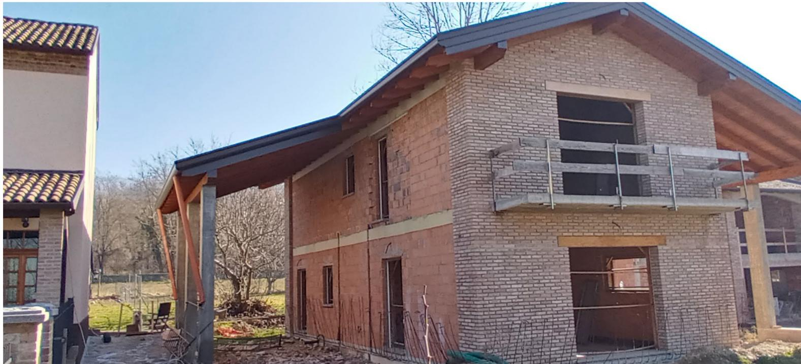
Villa sulle alture pavese: la ricostruzione di un finiele con la tecnica della muratura armata
