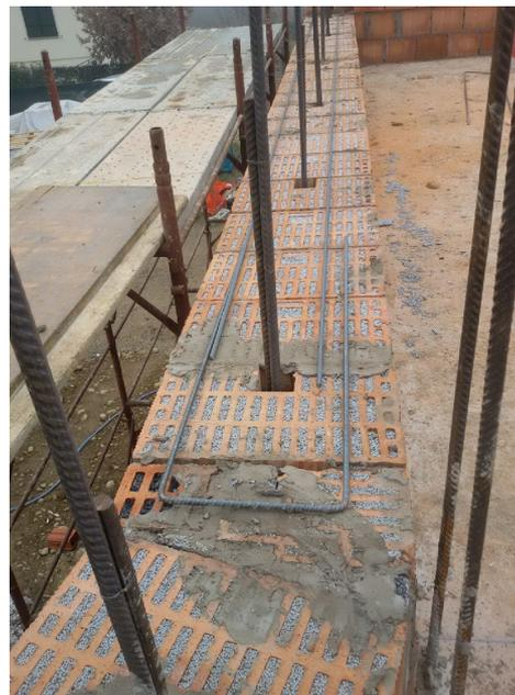
Villa sulle alture pavese: la ricostruzione di un finile con la tecnica della muratura armata
