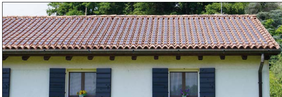
Tegole fotovoltaiche e coppi fotovoltaici, in laterizio, con applicati in superficie strati utili a convertire l'energia solare.
