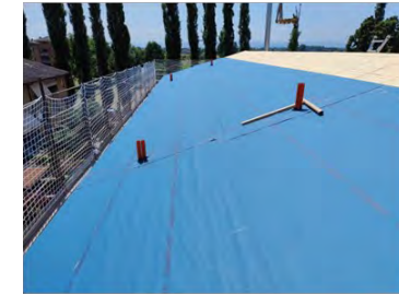
Telo impermeabile e traspirante a protezione della struttura lignea
