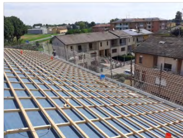
Sottostruttura di listelli per tegole
