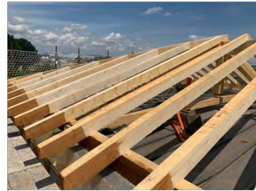
Sottostruttura di listelli per tegole
