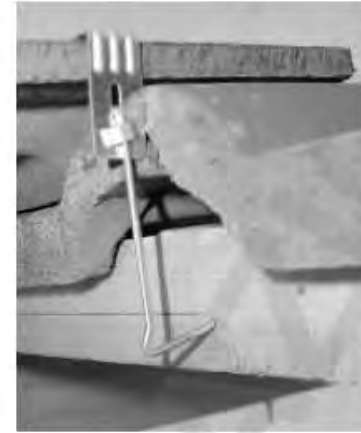
figura 46 Esempio di fissaggio con vite autofilettante
