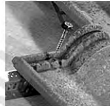
figura 46 Esempio di fissaggio con vite autofilettante
