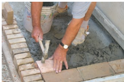
Tecnica di posa "a muratura".
