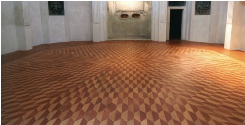
P. Tacci. Pavimentazione in piastrelle di cotto fatto a mano all'Archivio di Stato di Mantova.
