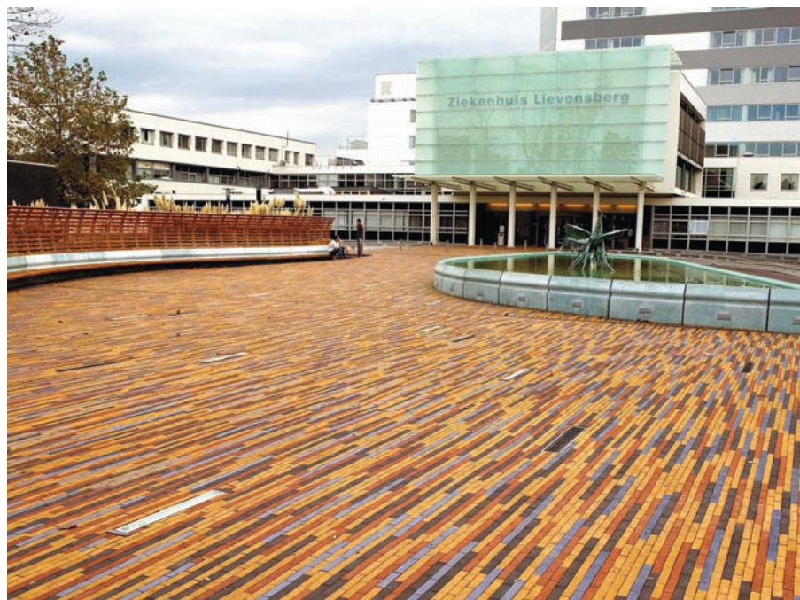
N. Korteweg e N. Zimmerman. Pavimentazione laterizia dell'entrata dell'ospedale di Bergen op Zoom (NL).
