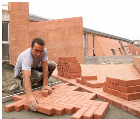
Pavimento in sestini posato con la tecnica "a spolvero".
