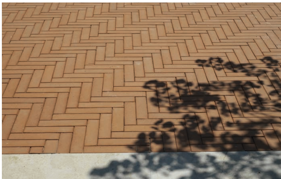
Pavimento in sestini estrusi con protezione idrorepellente a base di silossani in soluzione acquosa.
