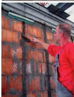
**Fig 1** Sistema costruttivo con armatura orizzontale e verticale inserita superficialmente (Grecia) / Construction system with horizontal and vertical reinforcement inserted on the surface (Greece)
