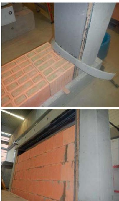
**Fig 7** Posa in opera della tamponatura accoppiata al telaio mediante elementi elastomerici (Germania)
