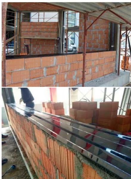
**Fig 4** Costruzione della tamponatura dell'edificio testata su tavola vibrante e dettaglio del profilo plastico del sistema a giunti scorrevoli (Pavia, Italia) / Masonry infills installation of prototype build tested on shake table and detail of the plastic profile developed of the sliding joint system (Pavia, Italy)
