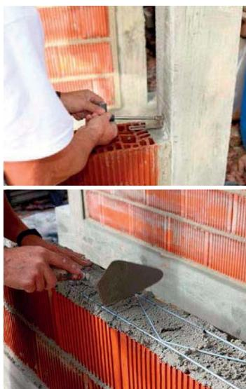
**Fig 2** Sistema costruttivo con armatura orizzontale collegata al pilastro (Portogallo) / *Construction system with horizontal reinforcement attached to the column (Portugal)*
