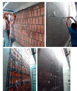
**Fig 3** Sistema con rete metallica nell'intonaco, con rete di rinforzo aramidica e connettori, con pannello d'isolamento e connettori, con bande in polipropilene e ancoraggi meccanici (Turchia e Romania) / *System with metallic mesh in the plaster, with aramid reinforcement mesh and connectors, with insulating panel and connectors, with polypropylene strips and mechanical anchors (Turkey and Romania)*
