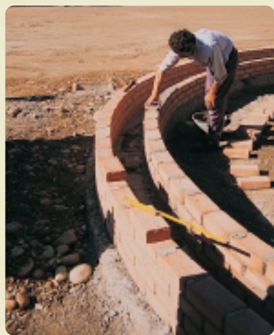
POSA DI UN MURETTO CURVO DI SPESSORE PARI A QUATTRO TESTE
