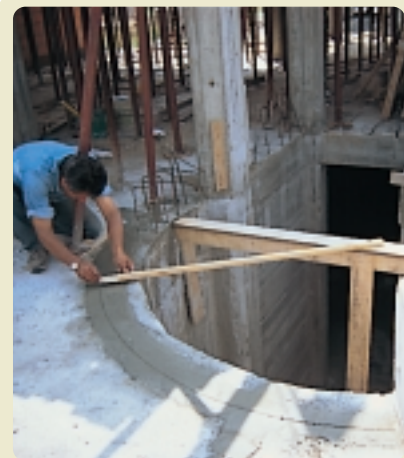
IL TRACCIAMENTO DELLA CURVA DI RIFERIMENTO SU UN LETTO DI MALTA FRESCA
