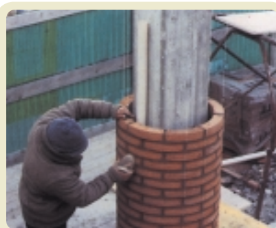
POSA DEL RIVESTIMENTO LATERIZIO INTORNO A UN PILASTRO IN C. A.
