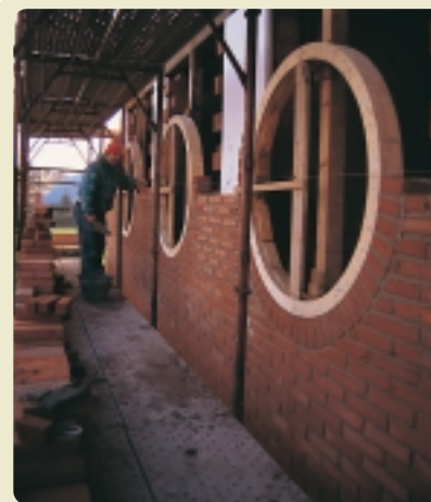
CENTINE ANCORATE ALLA STRUTTURA PRIMA DELLA POSA DEI MATTONI
