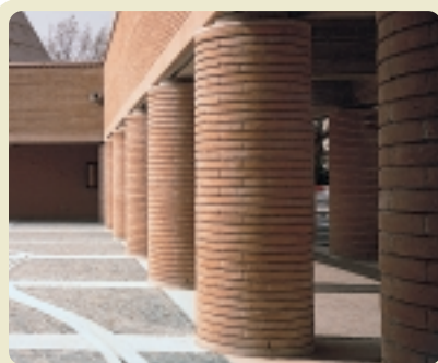
PILASTRI IN C.A. RIVESTITI IN LATERIZIO (M. BOTTA, CHIESA A PORDENONE)
