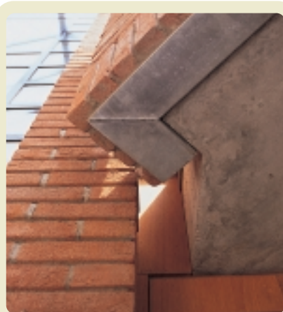
M. BOTTA, CASA A MANNO (CH), LA MENSOLA CHE SUPPORTA LA MURATURA IN AGGETTO
