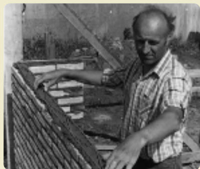
UN TRALICCIO VIENE POSATO SULLA MALTA APPENA STESA
