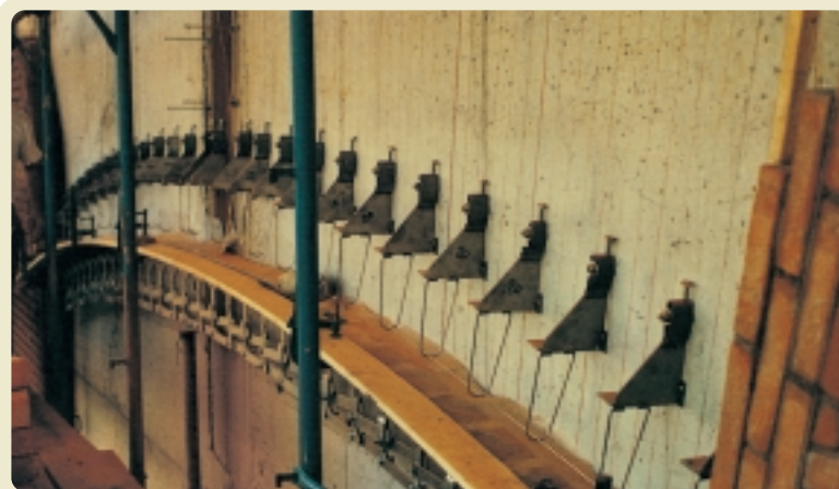
M. BOTTA, SUPERMERCATO A FIRENZE, LE MENSOLE CHE DOVRANNO SOSTENERE L'ARCO
