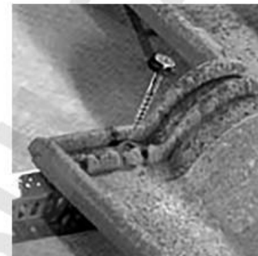
figura 46 Esempio di fissaggio con vite autofilettante
